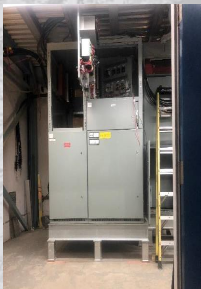
Ci-dessus : Surélévation de l'équipement électrique et du plancher de la salle électrique et surélévation du plancher de la baie de pompage de la station de pompage de Musquash.
