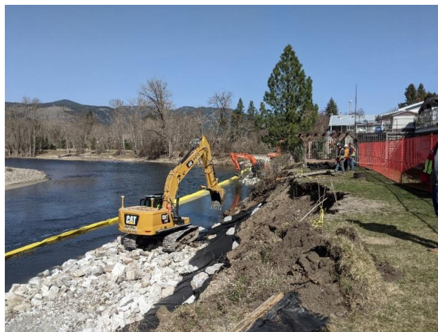
Installation d'un revêtement sur la rivière Kettle pour freiner l'érosion après les crues de 2018 et de 2020.
